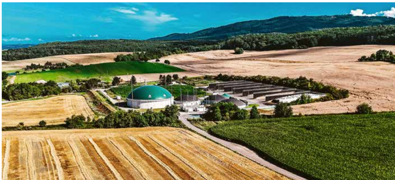
Realizace biometanové stanice Krakovičky
