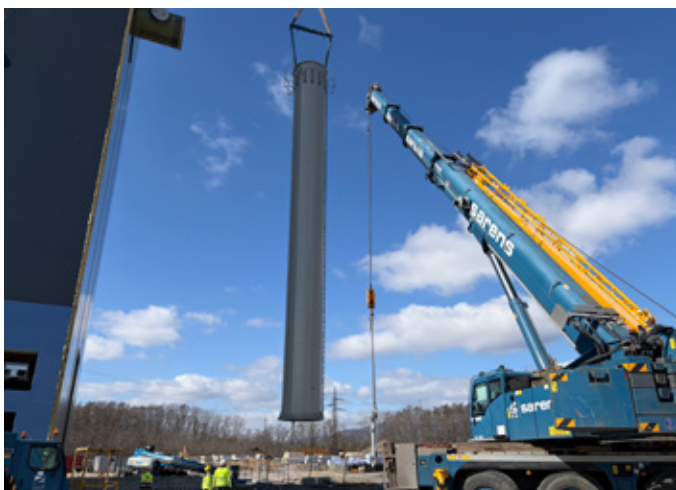
Zdvih komína o celkové výšce 75 metrů
