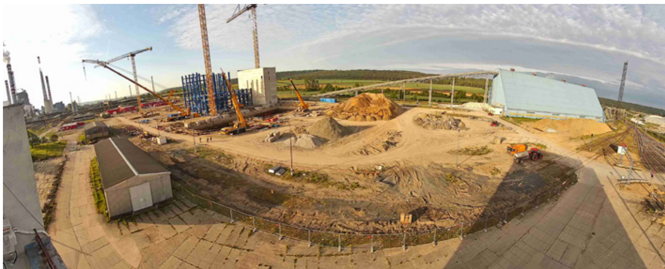
Probíhající výstavba ZEO Mělník
