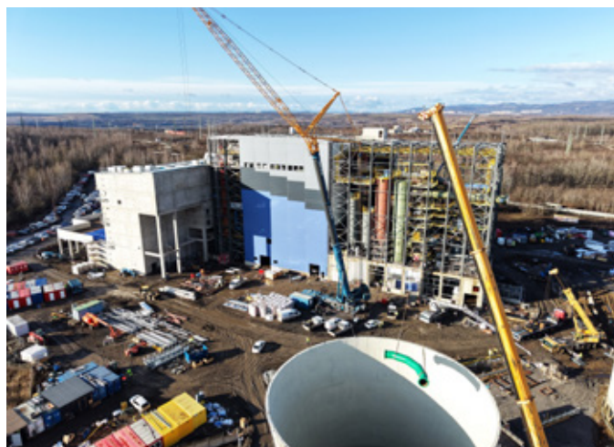
Stavba ZEVO Komořany
