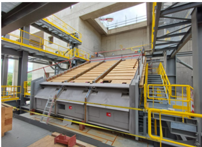
Pohled na rošt, na kterém se spaluje odpad
