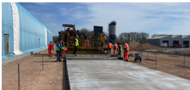
Ukládání a betonu finišerem
