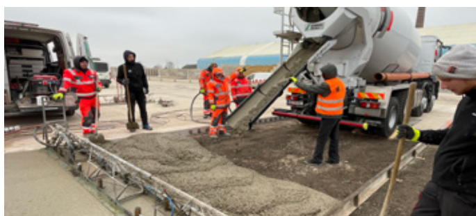
Ukládání betonu z automichače
