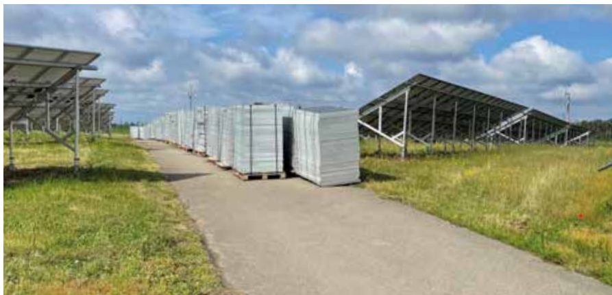
Vyřazené a poškozené panely v areálu elektrárny Pánov připravené k odvozu ke zpracovateli
