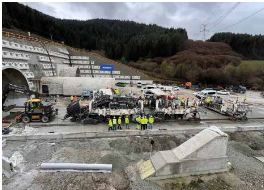
Betonáž pilotního projektu na stavbě D0 u Prahy
