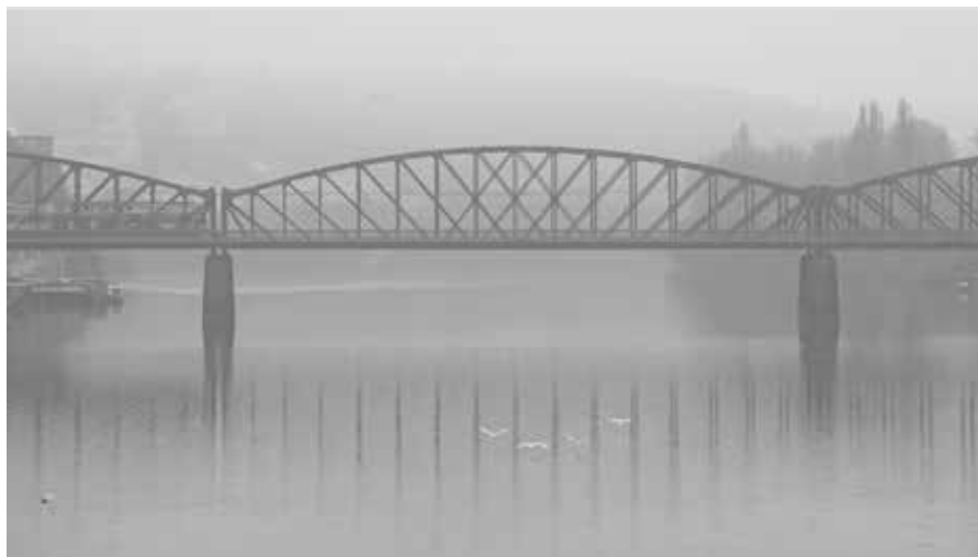
Vyšehradský železniční most (Výtoňský most)
